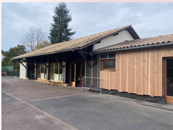
Isolation en bardage de la garderie, cantine et la classe de maitresse Séverine (PS-MS)
