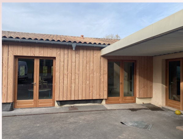
Isolation en bardage de la garderie, cantine et la classe de maitresse Séverine (PS-MS)
